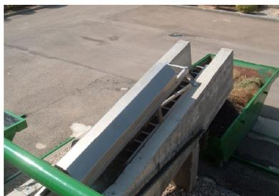
Sistema que permite separar as areias da matéria orgânica. A água é colocada no classificador e por gravidade os sólidos mais pesados são depositados. Um parafuso encarrega-se de os transportar e depositar na zona de acumulação de areias. O classificador geralmente é usado após a remoção de sedimentos provenientes da desarenação.
