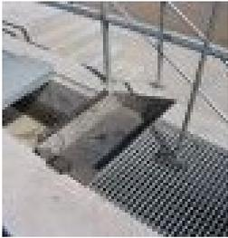
Grelha para locais com caudal e dimensão reduzida. Também é usada como proteção na gradagem, em canais de grandes dimensões (espaçamento entre 100 a 150 mm).
